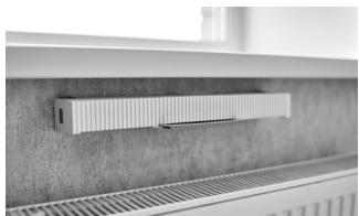
Проветривает вместо открытого окна, борется с духотой, плесенью и конденсатом на окнах, при этом не снижает шумоизоляцию окна. Не требует специального обслуживания. Важным условием его правильной работы является исправность вытяжных каналов на кухне и в санузлах.
